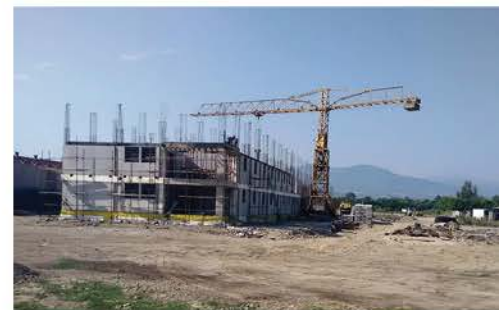
Výstavba a rekonštrukcia objektov – nápravné zariadenie IDRIZOVO, Macedónsko
