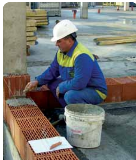
Vladimír Ferenčík pri kladení obvodového plášťa Domu seniorov v Michalovciach.
