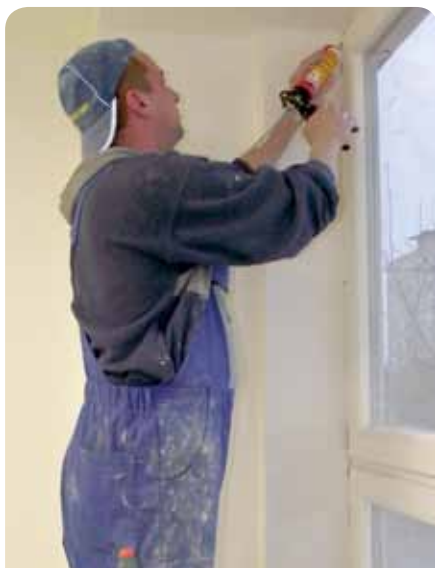
Daniel Janič pri svojej obvyklej činnosti. Práve dokončuje tmelenie okien v Poprade.
